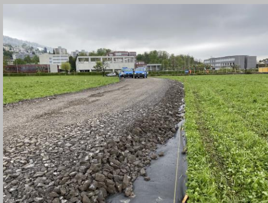
Gewährleistung des Schutzes temporär beanspruchter Böden
