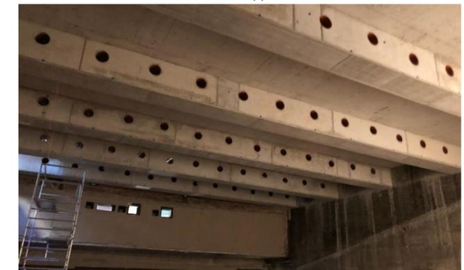
Neue Betondecke mit Unterzügen (Spannweite ca. 15 m)
