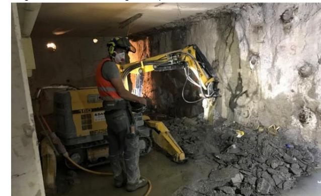
Vorarbeiten für Baugrubensicherung unter beengten Platzverhältnissen
