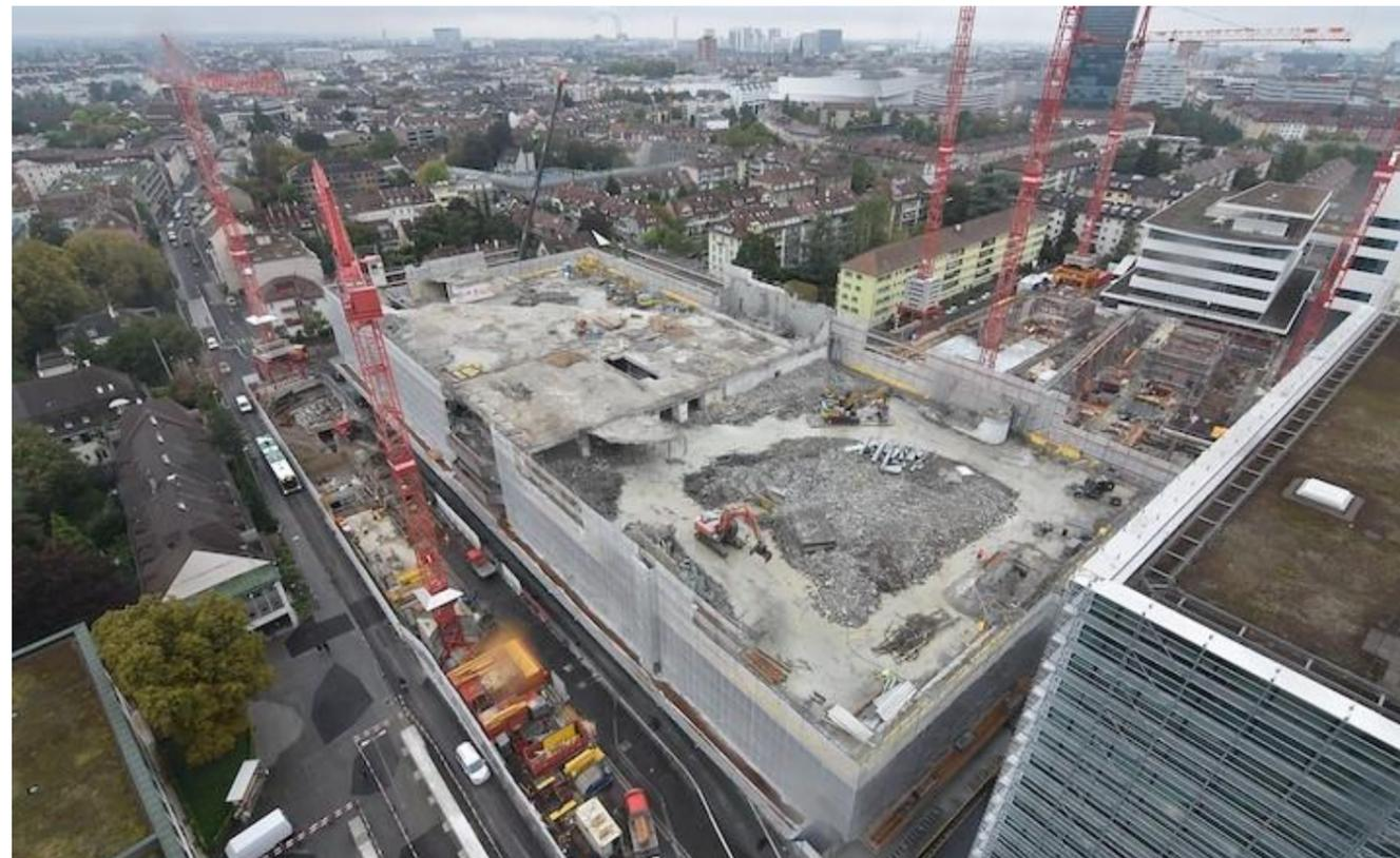
Oberirdischer Rückbau floor by floor im Schutze eines Gerüsts
