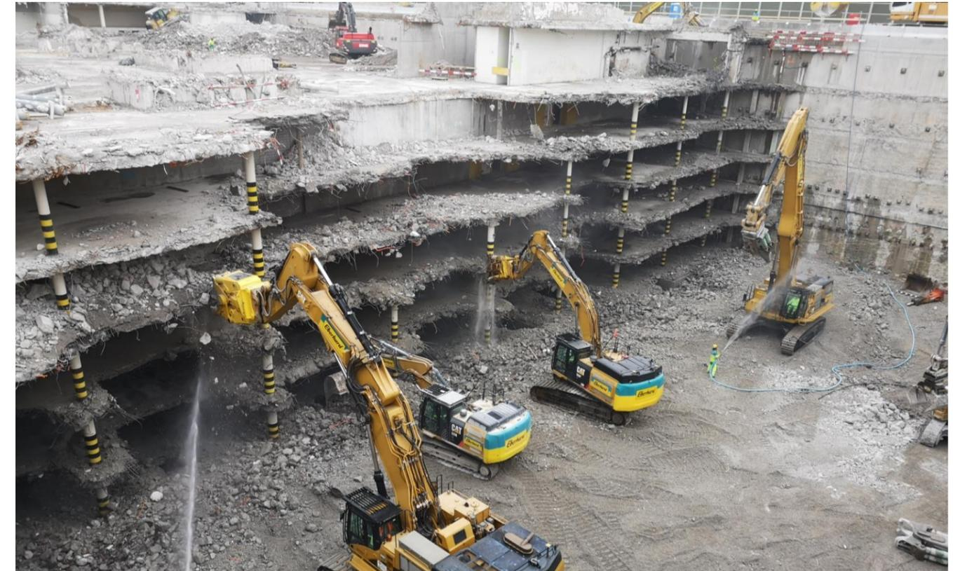
Unterirdischer Rückbau - Einsatz von mehreren Grossgeräten
