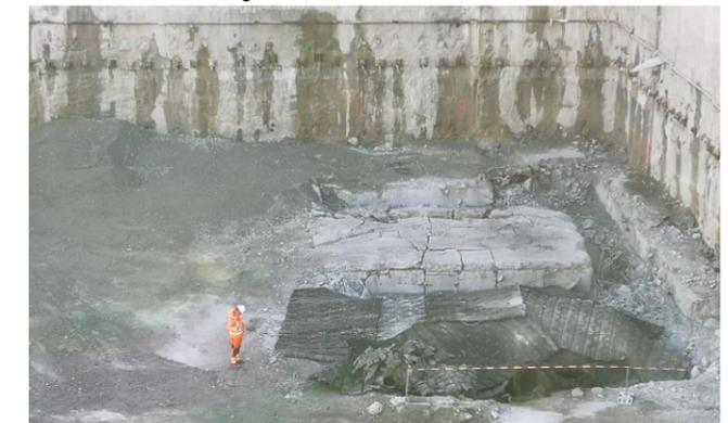
Fundament nach Lockerungssprengung
