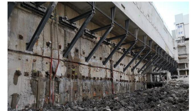
Mittels Stahlkonsolen gesicherter ELT
